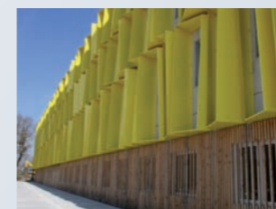
Le TIC - Hub Créatic à Nantes Maître d'ouvrage : Nantes Métropole Aménagement Maître d'œuvre : Cabinet TETRARC Constructeur métallique : EMFA (Les Sorinières - 44)
