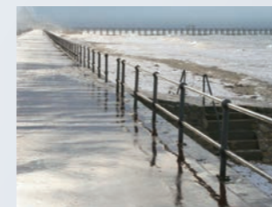
Digue de Luc-Sur-Mer Constructeur métallique : FRAMETO (Carpignat - 14)
